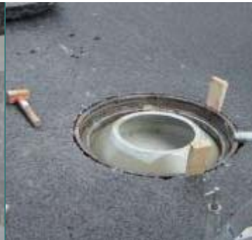
Fachgerechte Deckelanschlüsse
